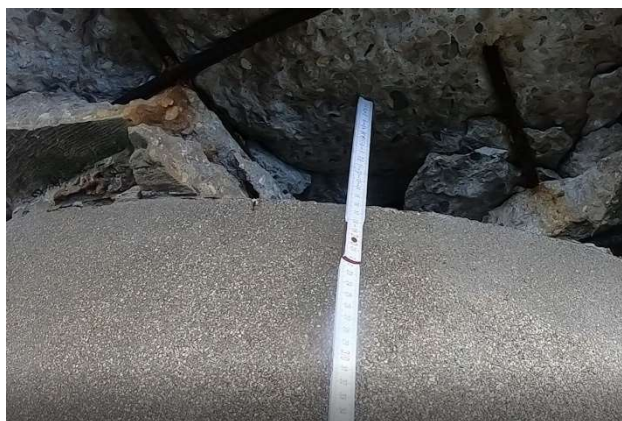
Att.4. Atdarpāja Nr.3 čaulpāļu savienojums ar virsbūvi.
